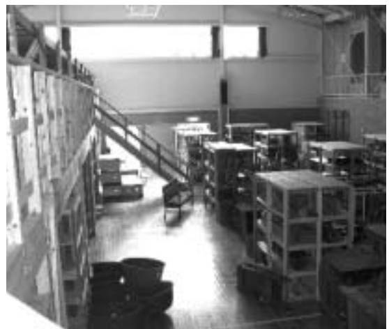
旧小国中学校体育館の改修の様子
