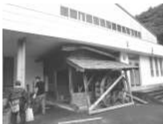
水車小屋の移設状況
